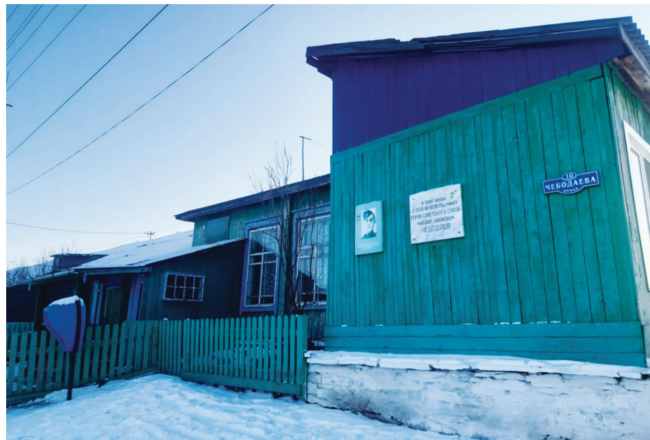
Школа до ремонта...
