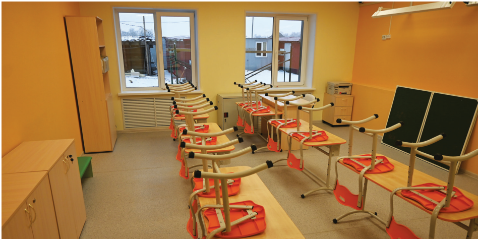
Так кабинеты выглядели до ремонта
