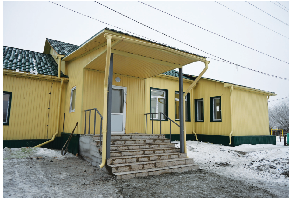
...и после ремонта
